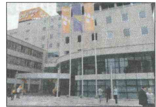
Zgrada „BH Telecoma“ u ulici Franca Lehara
